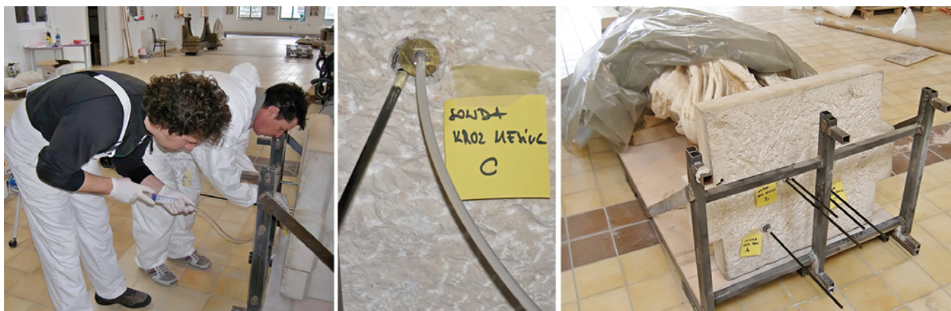
Slika 11. Postavljanje šipki od karbonskih vlakana
