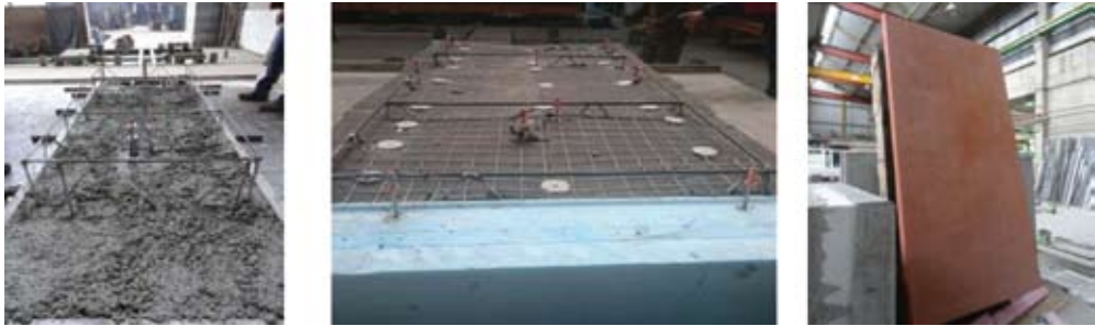
Slika 6: Faze proizvodnje panela u tvornici predgotovljenih elemenata
