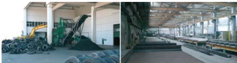
SI 2: Pogon za recikliranje otpadnih guma (Gumiimpex GRP) / pogon za proizvodnju RUCONBAR panela (Beton Lučko)
