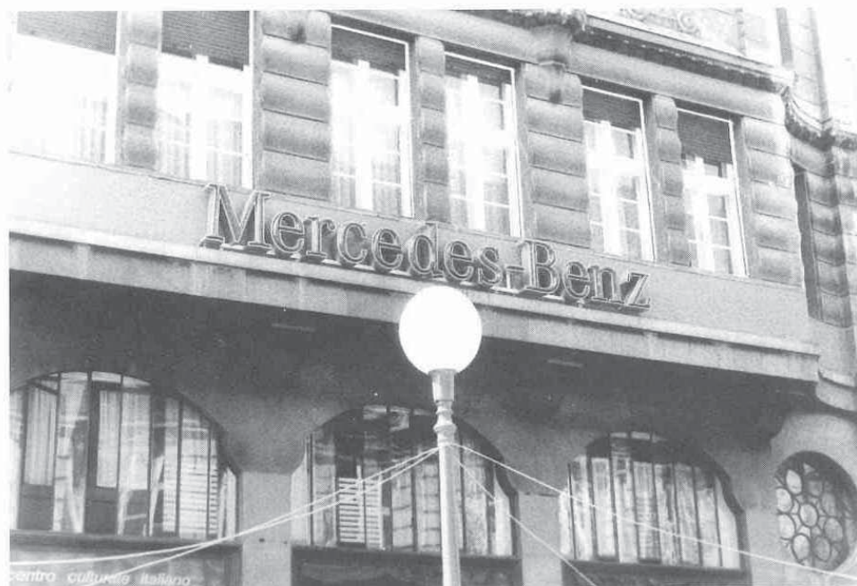
Kandelabar kao nosač improviziranih vodova u Preobraženskoj ulici / Candelabrum as a carrier of improvised lines in Preobraženska street
