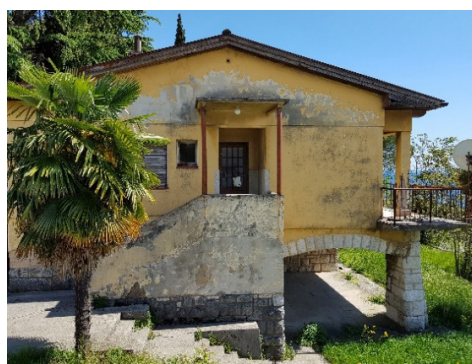
Slika 6. Zapadno pročelje stambene zgrade Istarska 29 – izvedeno stanje
