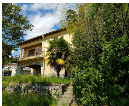
Slika 5. Dio južnog pročelja stambene zgrade Istarska 29 – izvedeno stanje
