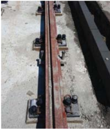
SI 4. Zagreb 21-CTT pričvršno mjesto prije fiksiranja sidrenoga vijka u beton
