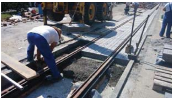
SI 5. Izrada opločenja kolosijeka na ispitnoj dionici, Savska cesta
