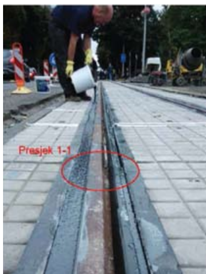
SI 6. Ugradnja materijala za zapunjavanje umjesto traka za brtvljenje
