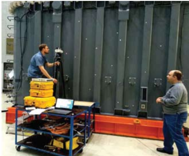
SI 1: Analizirani transformator u tvrtki Končar D&ST d. d.
