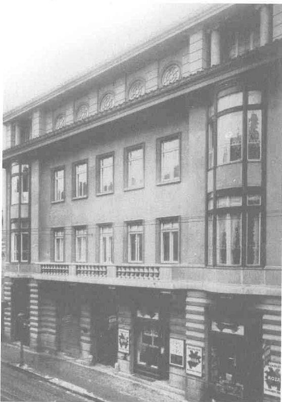
Pregradnja kuće Deutch u Jurišićevoj ulici, 1924. Izgled po dovršetku gradnje
