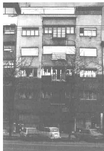
Zgrada Schlenger, Boškovićeva 7b, Zagreb, 1936./37. (Foto: M. Drmić, 1995.)
