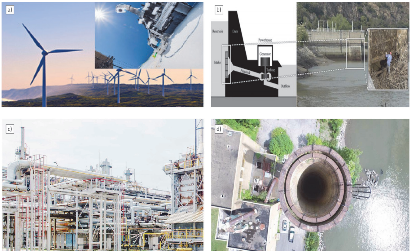
Slika 6. Pregled različitih tipova građevina korištenjem autonomnih sustava: a) vjetroagregat [15]; b) brane [16]; c) industrijske instalacije [17]; d) dimnjaci industrijskih postrojenja [18]
