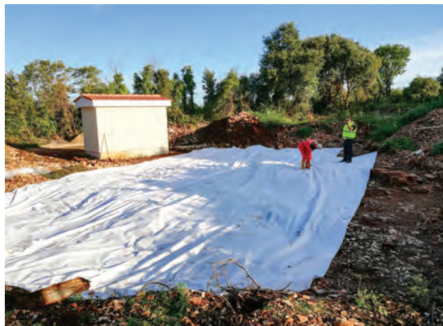
Sl. 8 Prekrivanje terena i arheološkog objekta geotekstilom (fotografija: R. Zlatunić).
