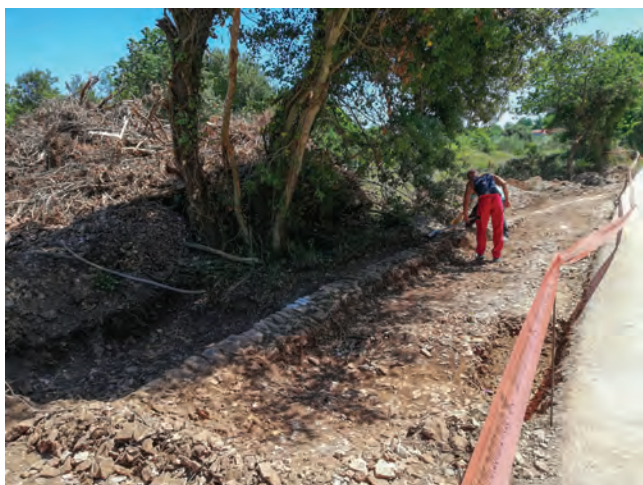
Sl. 13 Rubnici austrougarskog nabijenog puta nakon grubog ručnog čišćenja (fotografija: R. Zlatunić).
