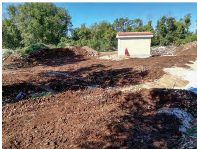
Sl. 10 Strojno nasipavanje dodatnim zaštitnim slojem zemlje (fotografija: R. Zlatunić).
