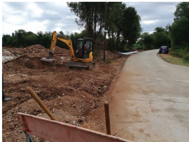
Sl. 20 Zatrpavanje austrougarskog nabijenog puta prekrivenog geotekstilom zaštitnim slojem građevinskog materijala (fotografija: R. Zlatunić).
