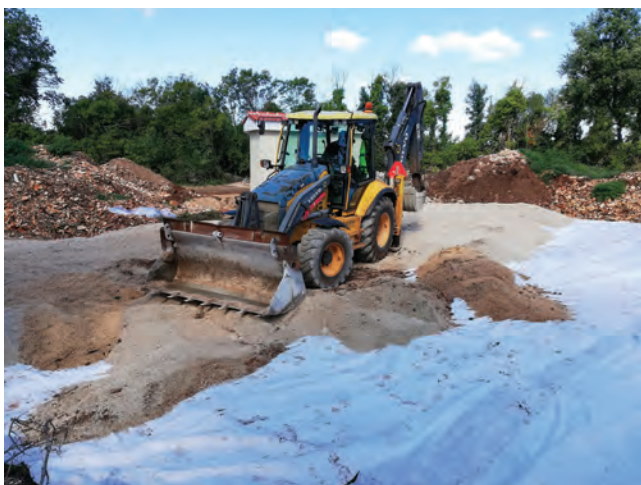
Sl. 9 Strojno zatrpavanje geotekstila zaštitnim slojem građevinskog materijala pijeskom i rizlom (fotografija: R. Zlatunić).
