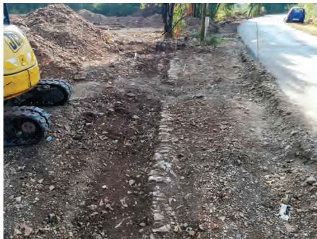
Sl. 12 Pogled na rubnike austrougarskog puta tijekom strojnog iskopavanja na području ceste prema Svetici ili Monte Madonni, koja se nalazi u blizini otkrivenog rimskog i kasnoantičkog ruralnog objekta (fotografija: R. Zlatunić).
