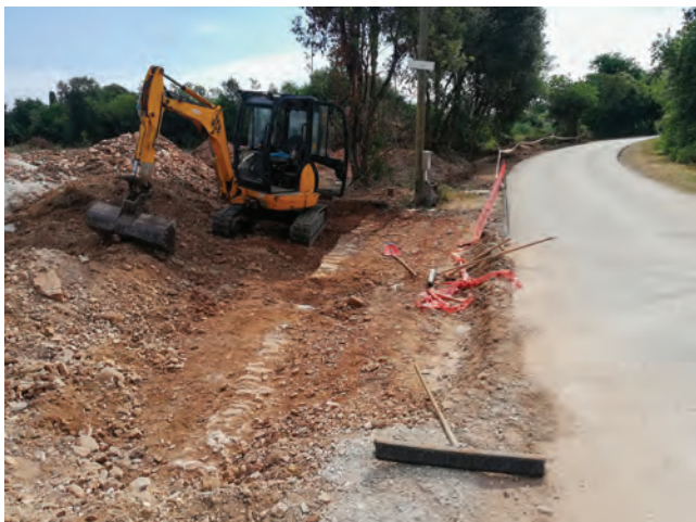
Sl. 15 Pogled na iskopanu trasu, gdje je registriran austrougarski nabijeni put s fino oblikovanim rubnim dijelovima od lomljenog kamena (fotografija: R. Zlatunić).
