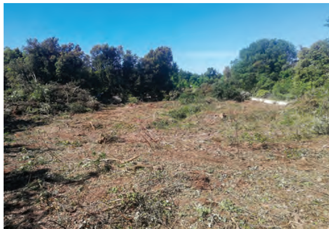
Sl. 2 Pogled na mjesto nakon skidanja i čišćenja zelene površine. Vidljiva je trasa rova JNA (fotografija: R. Zlatunić).
