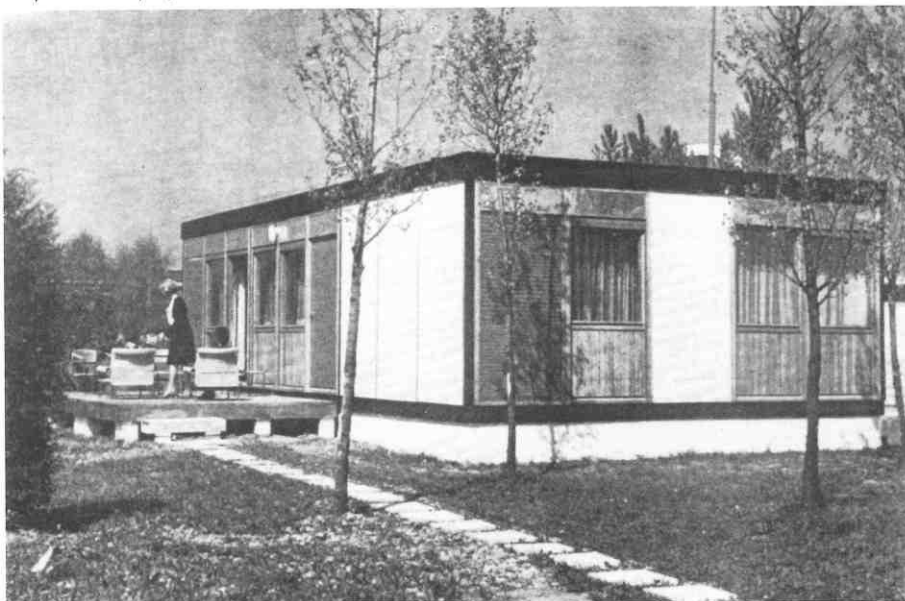
B. Budimirov, V. Robotić, Z. Žokaj, Ž. Solar, montažna kuća "Spačva" S301, 1963.
