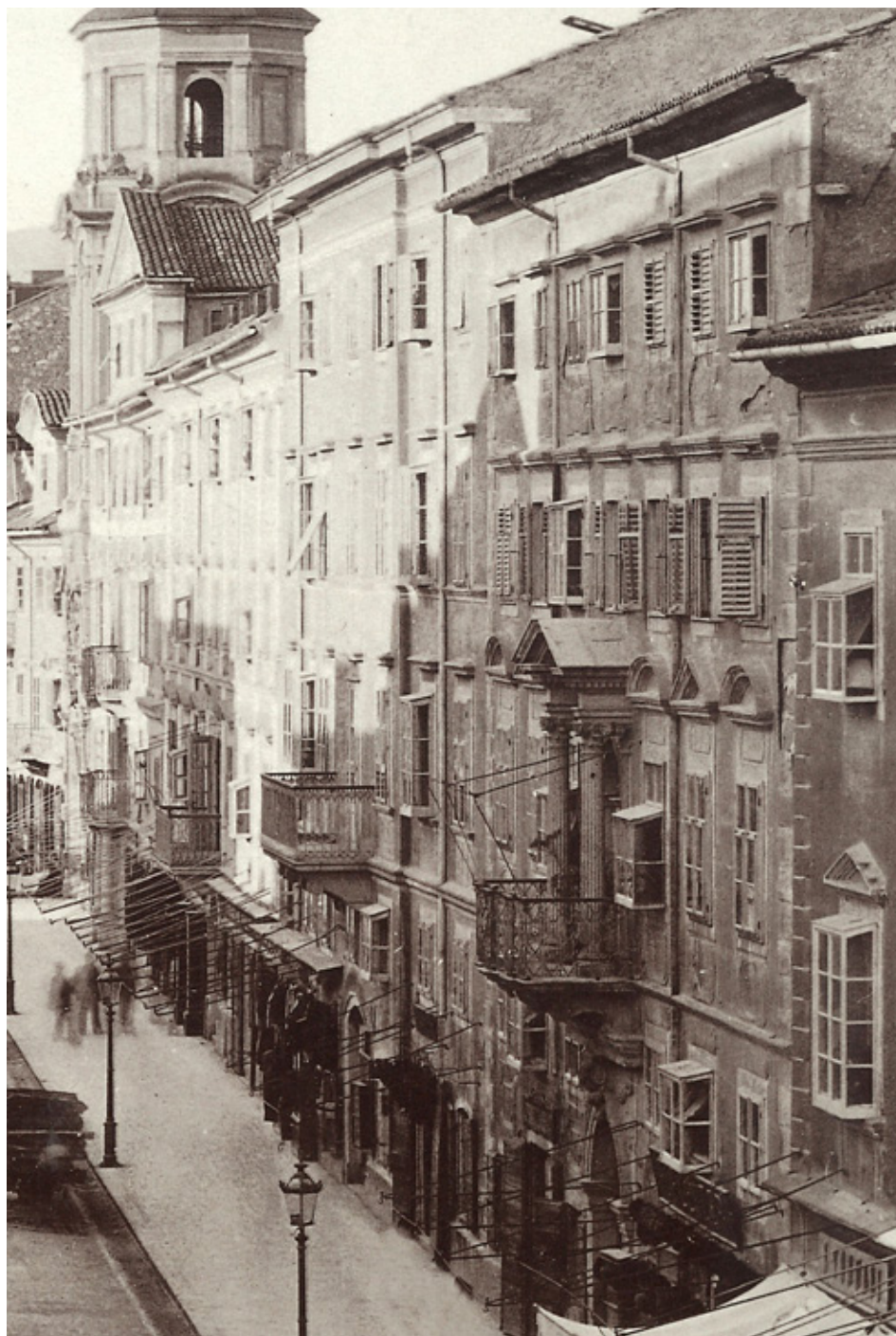
6. Palača Bolf (desno) s edikulom na prvom katu te naknadno nadograđenim trećim katom, detalj fotografije iz 80-ih godina 19. stoljeća (Konzervatorski odjel u Rijeci)
