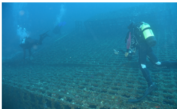
2. Otok Lastovo, nalazište Saplun, stanje zaštitnog kaveza 2016. godine (arhiva HRZ-a, snimka: P. Dugonjić, 2016.) Island of Lastovo, Saplun site, condition of the cage in 2016 (HRZ Photo Archive, P. Dugonjić, 2016)
