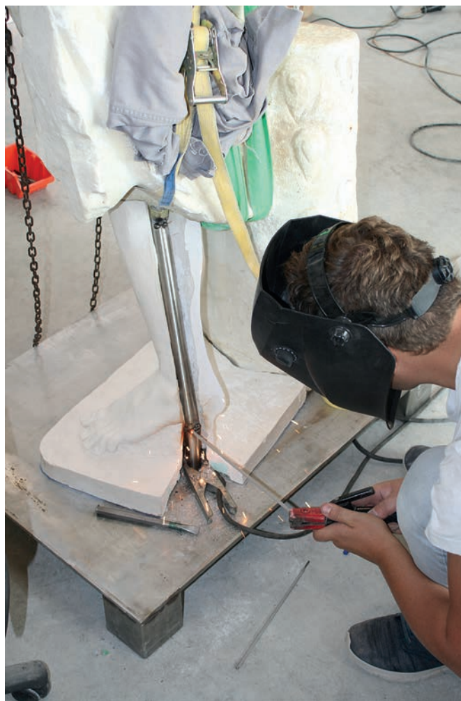
Slika 26. Zavarivanje spojnih točaka proteze (foto: B. Vješnica)
