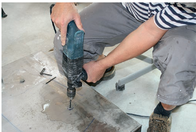
Slika 22. Bušenje ucrtanih položaja na nosivoj podlozi za fiksiranje skulpture (foto: D. Ordulj)
