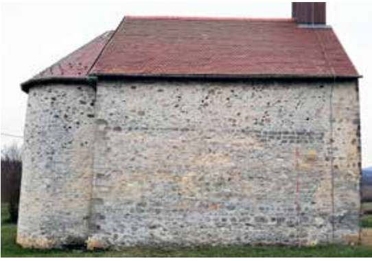
9 Martin, crkva sv. Martina, sjeverni zid broda crkve – zid od priklesanog kamena u horizontalnim redovima (13. st.) do visine 5,20 m (foto: R. Ivanušec, 2021.)
