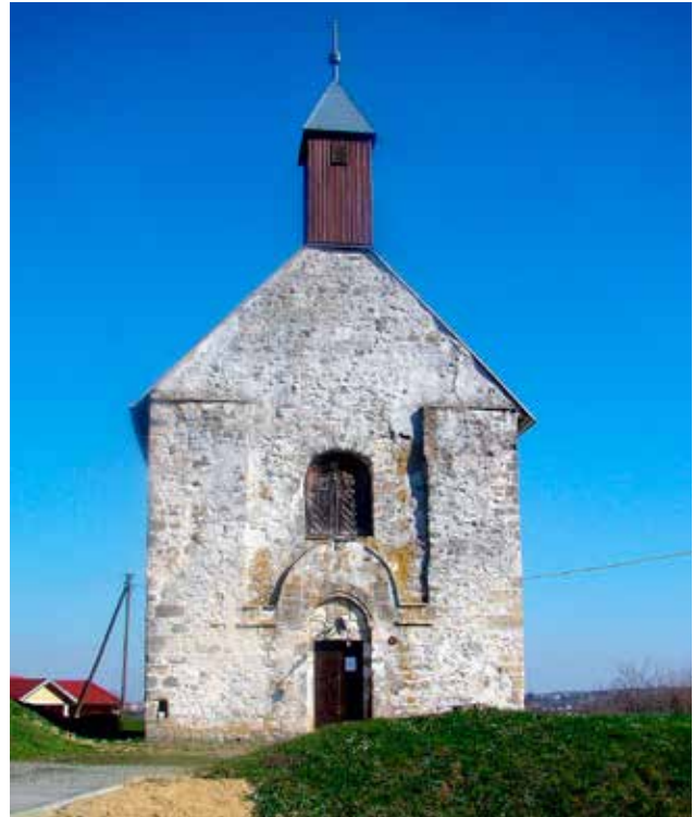
10 Martin, crkva sv. Martina, zapadno pročelje – postojeće stanje (foto: R. Ivanušec, 2021.)
