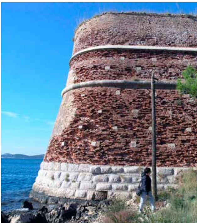
6 Kameni umetci na jugozapadnom polubastionu tvrđave sv. Nikole (foto: I. Glavaš, 2017.)
