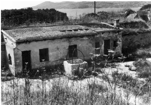
8 Objekti na kurtini između polubastiona tvrđave sv. Nikole (foto: J. Čuzela, 1979.)
