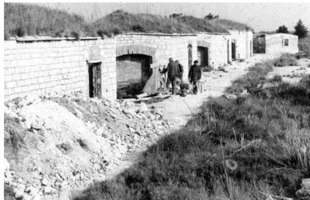
9 Austrijske prostorije za smještaj posade i projektila između topovskih otvora na tvrđavi sv. Nikole (foto: J. Čuzela, 1981.)
