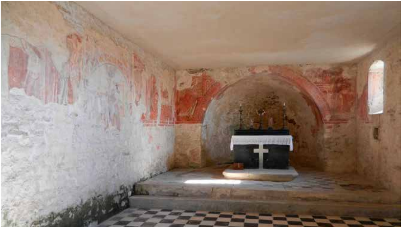
14 Stanje u unutrašnjosti prije početka cjelovitog konzervatorsko-restauratorskog zahvata (foto: N. Nefat, 2014.)
