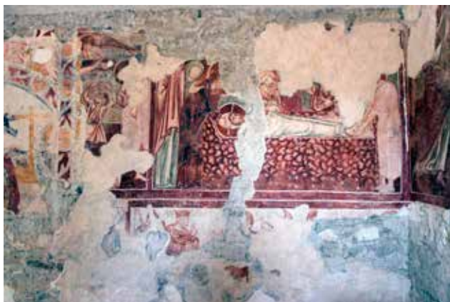
19 Sjeverni zid, Polaganje u grob , stanje nakon čišćenja zidnih slika te postava žrtvene žbuke (foto: M. Fernežir, 2018.)
