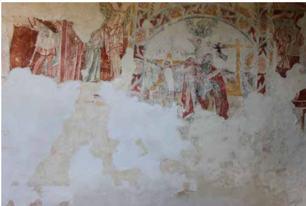
21 Nanošenje toniranoga vapnenog naliča na ožbukane lakune na sjevernom zidu (foto: M. Fernežir, 2020.)
