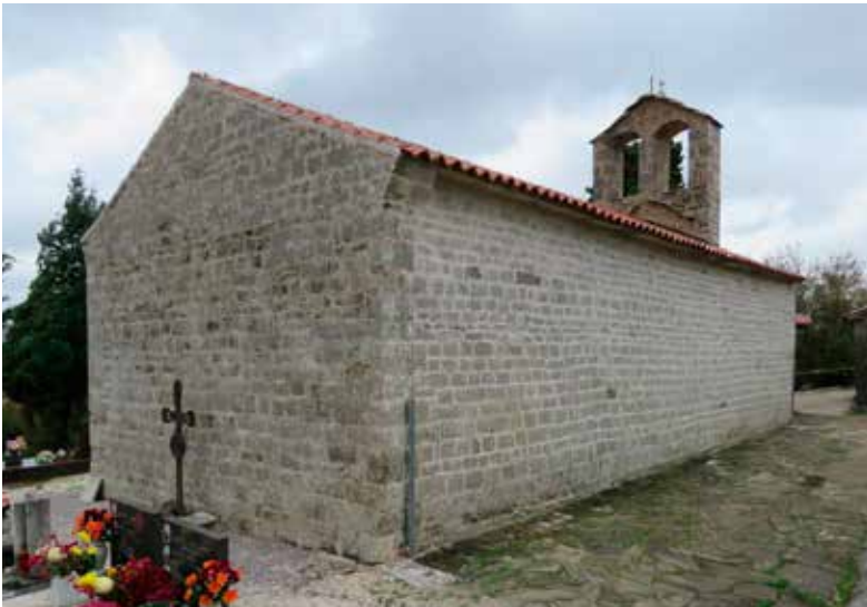
16 Sjeverni zid crkve nakon fugiranja (foto: N. Nefat, 2019.) Northern wall after grouting (photo: N. Nefat, 2019)
