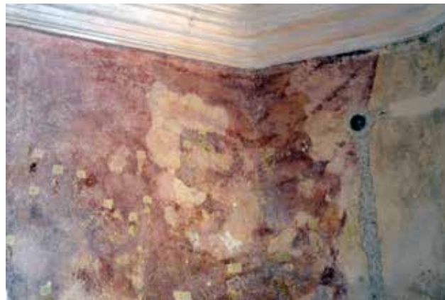
15 Sjeverni, sjeveroistočni i sjeverozapadni zid kapele tijekom radova (foto: L. Košćević, 4. 8. 2015.)
