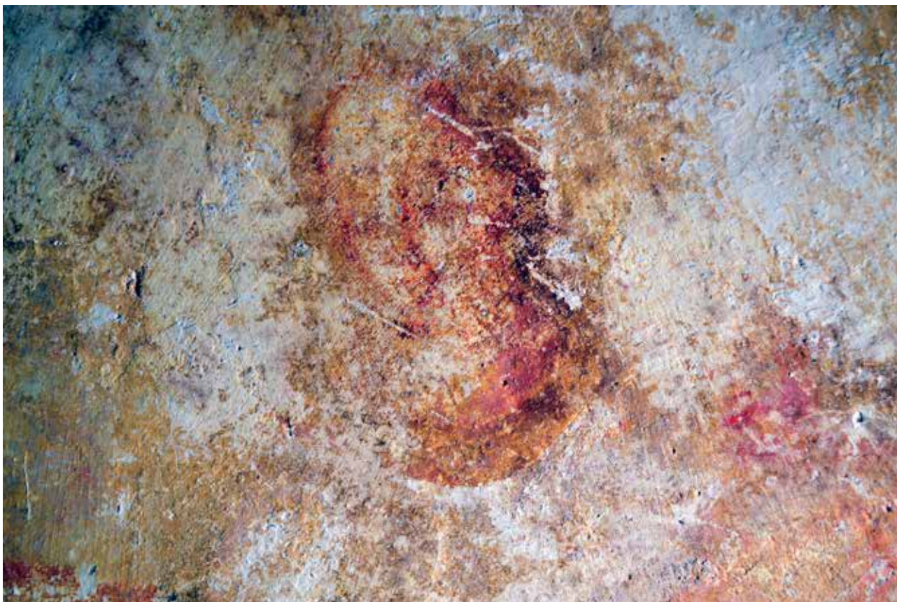
7 Detalj zidnog oslika na svodnom segmentu 3 nakon čišćenja. Oslik je sačuvan fragmentarno, a neki su dijelovi otpali, tako da su vidljive samo njihove siluete na sloju intonaco . (foto: L. Košćević, 31. 10. 2013.)
