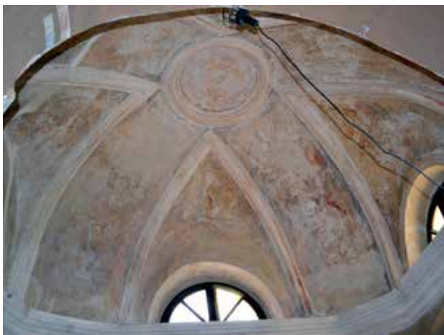
4 Sjeverni dio svoda kapele – stanje nakon radova izvedenih 2013. (foto: L. Košćević, 31. 10. 2013.)
