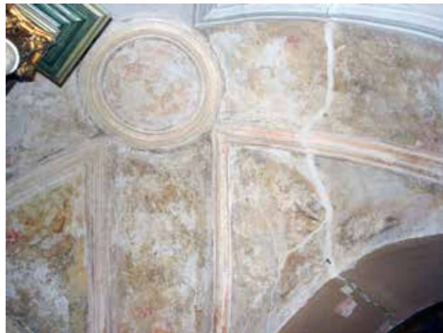
3 Južni dio svoda kapele – stanje nakon radova izvedenih 2012. (foto: L. Košćević, 14. 9. 2012.)
