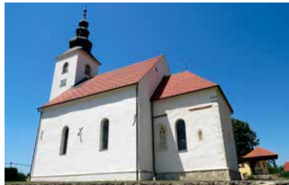
11 Konjščina, Župna crkva sv. Dominika, pogled na obnovljeno pročelje crkve s rekonstruiranom gotičkom biforom na svetištu 2021. (fototeka KOKR). Vrsta boje, proizvođač: silikatna, Keim (lađa), Samoborka (svetište). Godina obnove: 2011.-2013. (lađa), 2016. (svetište)
