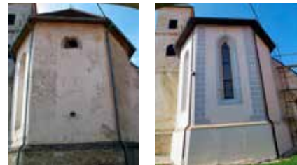
38, 39 Lobar, Crkva sv. Marije Gorske, pogled na svetište prije obnove 2011. i nakon obnove 2018. (fototeka KOKR). Vrsta boje, proizvođač: silikatna, Samoborka. Godina obnove: 2018. (svetište)
