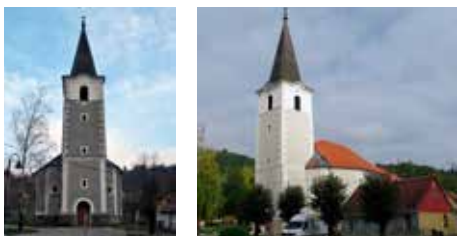
22, 23 Lobar, Župna crkva sv. Ane, pogled na glavno pročelje prije obnove 2011. i nakon obnove 2015. (fototeka KOKR). Vrsta boje, proizvođač: silikatna, Samoborka. Godina obnove: 2015.
