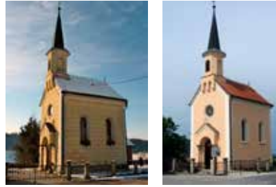
3, 4 Tugonica, Kapela sv. Roka, pogled na kapelu prije obnove 2010. i nakon obnove 2012. (fototeka KOKR). Vrsta boje, proizvođač: silikatna, Caparol. Godina obnove: 2012.
