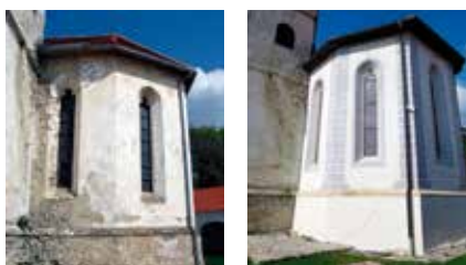
40, 41 Lobar, Crkva sv. Marije Gorske, pogled na svetište prije obnove 2009. i nakon obnove 2018. (fototeka KOKR). Vrsta boje, proizvođač: silikatna, Samoborka. Godina obnove: 2018. (svetište)
