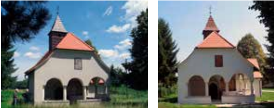
1, 2 Kuzminec, Kapela sv. Marije Magdalene, pogled na zapadno pročelje prije obnove 2010. i nakon obnove 2011. (fototeka Konzervatorskog odjela u Krapini). Vrsta boje, proizvođač: silikatna, Caparol. Godina obnove: 2011.
