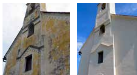
34, 35 Desinić, Kapela sv. Ane, pogled na glavno pročelje prije obnove 2009. i nakon obnove 2018. (fototeka KOKR). Vrsta boje, proizvođač: silikatna, Caparol. Godina obnove: 2018.
