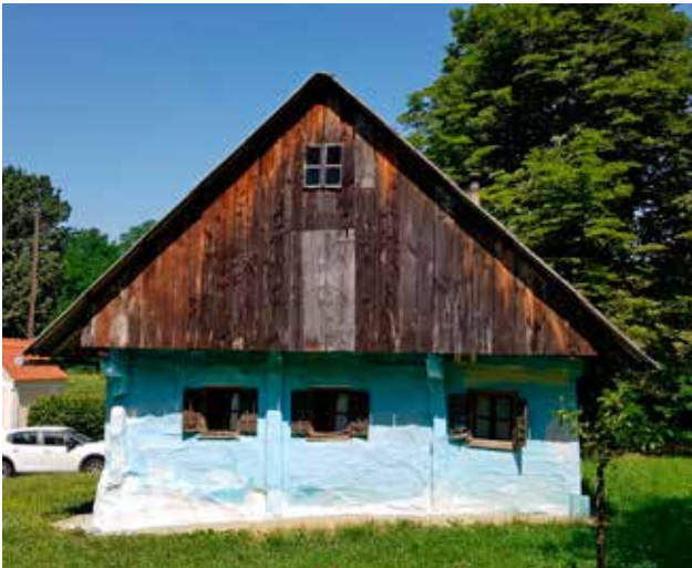
2 Zagorska Sela, Tradicijska drvena kuća - hiža mazanka, oličena mješavinom vapnenog mlijeka i modre galice (fototeka Konzervatorskog odjela u Krapini)
