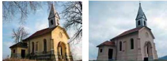
20, 21 Hršak Breg, Kapela sv. Antuna, pogled na kapelu prije radova 2011. i nakon radova 2016. (fototeka KOKR). Vrsta boje, proizvođač: silikatna, Keim. Godina obnove: 2015.
