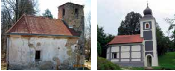
28, 29 Klanjec, Kapela sv. Florijana, pogled na sjeverno pročelje prije obnove 2011. i nakon obnove 2016. (fototeka KOKR). Vrsta boje, proizvođač: silikatna, Keim. Godina obnove: 2011.-2016. (Obnovu kapele vodila je Ksenija Petrić iz Konzervatorskog odjela u Zagrebu.)
