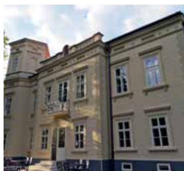
26, 27 Bračak, Dvorac Kulmer, pogled na južno pročelje prije obnove 2011. (foto: D. Boić) i nakon obnove 2017. (fototeka KOKR). Vrsta boje, proizvođač: silikatna, Caparol. Godina obnove: 2016.
