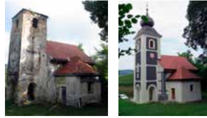
30, 31 Klanjec, Kapela sv. Florijana, pogled na južno pročelje prije obnove 2010. i nakon obnove 2016. (fototeka KOKR). Vrsta boje, proizvođač: silikatna, Keim. Godina obnove: 2011.-2016.
