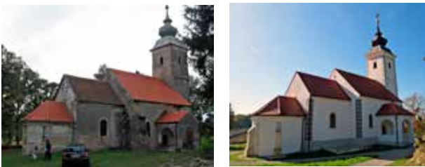
5, 6 Gotalovec, Kapela sv. Petra, pogled na kapelu prije radova 2009. i nakon radova 2017. (fototeka KOKR). Vrsta boje, proizvođač: silikatna, Caparol. Godina obnove: 2010.-2016.
