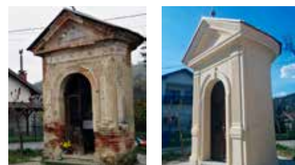
42, 43 Trški Vrh, Poklonac, prije obnove 2020. i poslije obnove 2021. (fototeka KOKR). Vrsta boje, proizvođač: silikatna, Caparol. Godina obnove: 2020.-2021.
