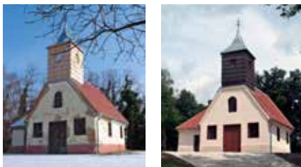
12, 13 Krapinske Toplice, Kapela sv. Marije Magdalene, pogled na kapelu prije obnove pročelja 2012. i nakon obnove 2014. (fototeka KOKR). Vrsta boje, proizvođač: silikatna, Caparol. Godina obnove: 2011. - 2014.
