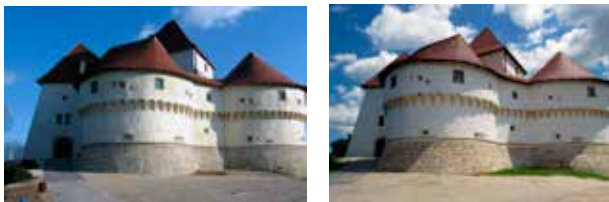
18, 19 Hum Košnički, Dvor Veliki Tabor - vanjski obrambeni prsten, pogled na pročelje nakon žbukanja a prije ličenja 2015. te pogled na pročelje nakon ličenja 2016. (fototeka KOKR). Vrsta boje, proizvođač: silikatna, Keim. Godina obnove: 2016. (Voditelj cjelovite obnove bio je Hrvatski restauratorski zavod.)
