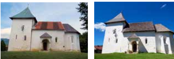
32, 33 Belec, Kapela sv. Jurja, pogled na kapelu prije obnove 2016. i nakon obnove 2021. (fototeka KOKR). Vrsta boje, proizvođač: vapnena, Sto. Godina obnove: 2018. (Obnovu kapele je, pod konzervatorskim nadzorom Konzervatorskog odjela u Krapini, vodio Hrvatski restauratorski zavod, voditeljica radova: Ana Škevin Mikulndra.)
