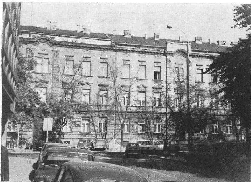
Dogradnje katova na Svačićevom trgu 15 i 16 povlače se od ulične fasade zgrade, a otvaraju na terase. Iz ulične razine intervencija je na staroj zgradi neprimjetna, a kvaliteta stanovanja u dogradnji neusporedivo viša i kompleksnija nego u standardnoj dogradnji po dogmi »jednaki prozorski otvori...«
