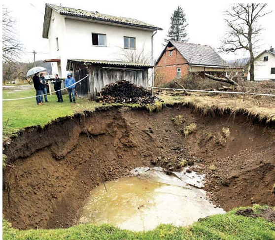
Slika 5. Druga po veličini urušena jama u Mečenčanima. Foto. T. Krišto Picture 5 Second collapse hole in Mečenčani
