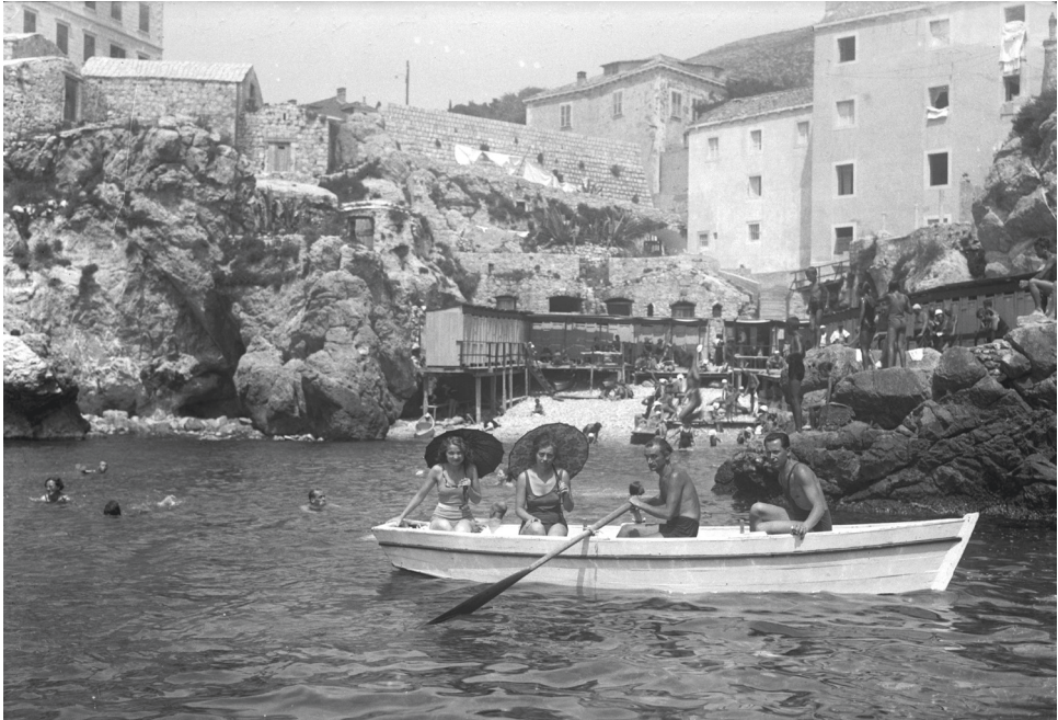
Slika 9. Kupalište u Šulici prije preuređenja (HR-DADU-988)
