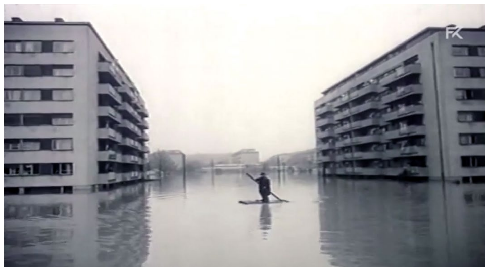
Slika 7. Poplavljena i novija stanogradnja
