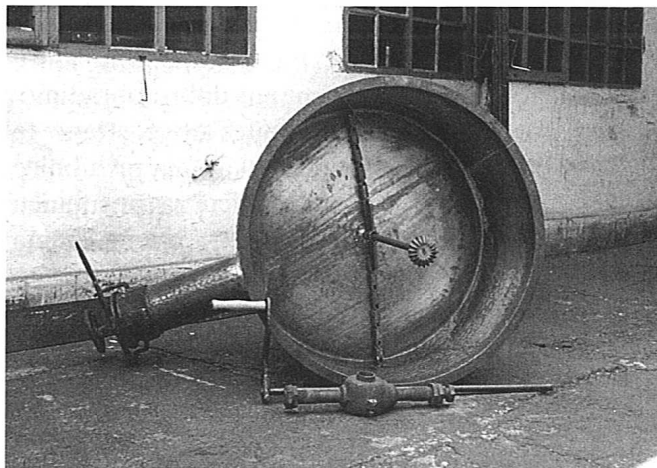
Slika 14. - Gornji kotao s bakrenim lancima za mješalicu pri dnu i ispred vidljivom mješalicom, s prikovanom ispusnom cijevi i zaptivnim vratima ispusta.
