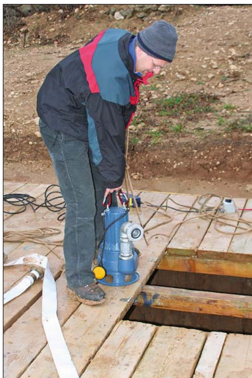
Spuštanje pumpe za ispušavanje vode iz bunara - kraja Talijanove buže
