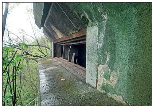
Na padinama Plješivice iznad podzemnog dijela aerodroma, kao bunker, izveden je kontrolni toranj
