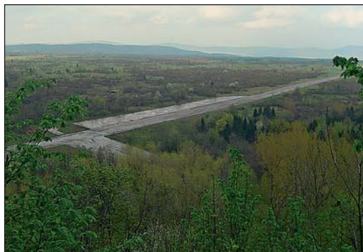
Pogled s kontrolnog tornja na APRON 1 i plato na kojem je smješteno ukupno pet pista
