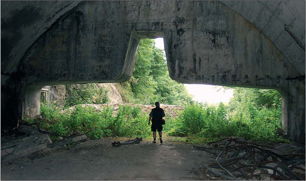
Pogled iz unutrašnjosti prilaznog hodnika na ulazu 2 - armiranobetonski zastor s prorezom za vertikalni stabilizator aviona dodatno je štiti unutrašnjost objekta
