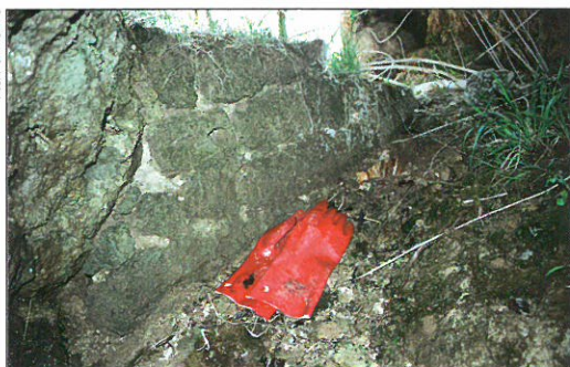
Dio zida na gornjem otvoru Vranjačke špilje
