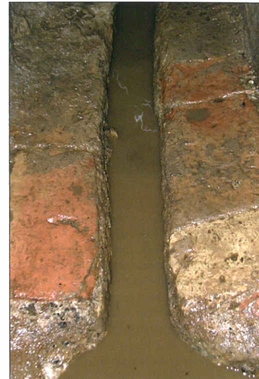
»Oprani« dio jarka tunela uz 5. odušnik
