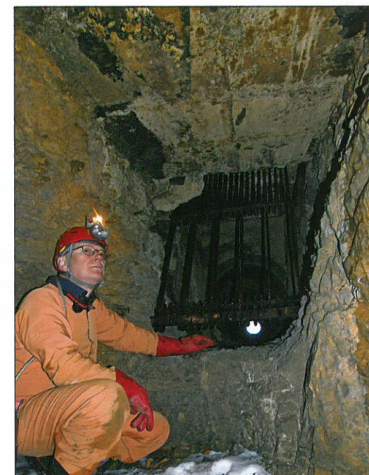
Rešetkom zatvorena prva kanalska cijev
