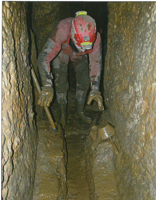
Čišćenje žlijeba tunela uz 3. odušnik
