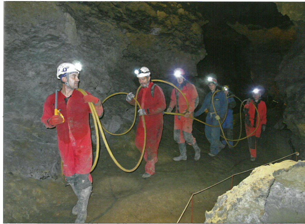
Noć šišmiša, Izvlačenje kabela iz Veternice
