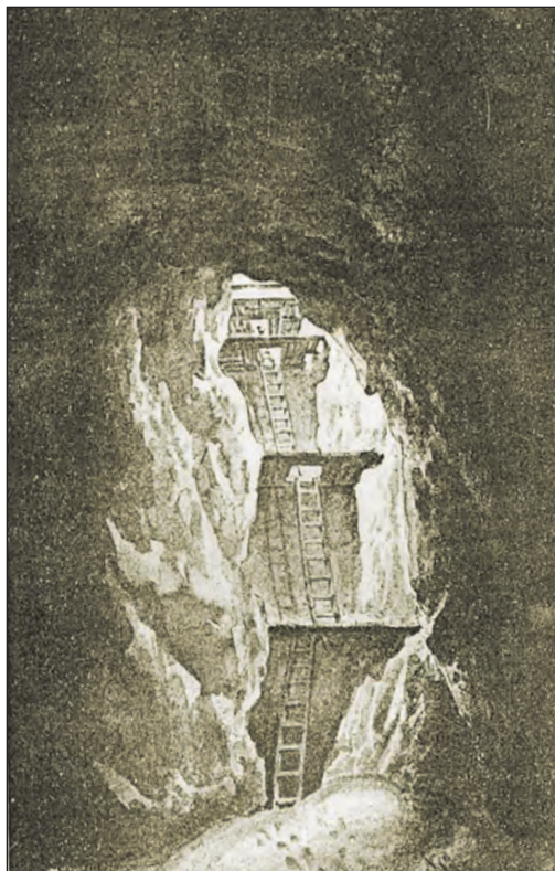
Način prodiranja u dubinu pomoću drvenih podesta sredinom 19. st.
