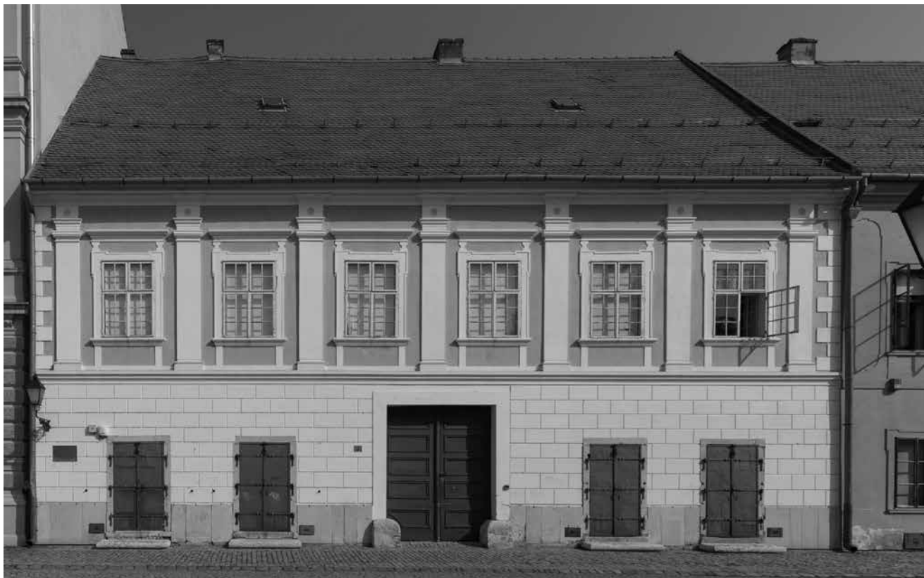
19. Kuća Nikolantin (Trg sv. Trojstva 5), pročelje (foto: Jovan Kliska, 2012.)
