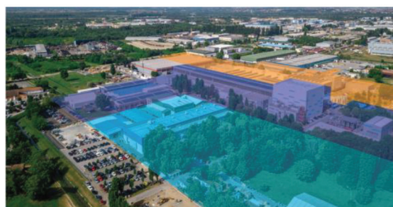
Slika 11 Pogled na lokaciju 2020. na kojoj se proizvode transformatori u tri društva: KONČAR – Energetski transformatori d.o.o. (ljubičasto), KONČAR – Distributivni i specijalni transformatori d.d. (oker) i KONČAR – Mjerni transformatori d.d. (tirkizno), koja je povećana u 20 godina za 2,1 puta
