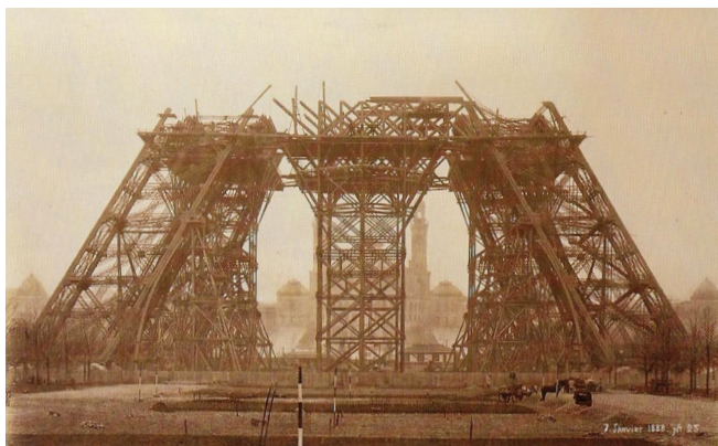
Slika 3 – Eiffelov toranj (ovdje prikazan u fazi izgradnje 1888. godine) trijumf je čovjeka nad silom težom. Unatoč gabaritima 125 \times 125 \times 300 metara, njegova konstrukcijska masa iznosi samo 7300 t. Kad bi se na njegovom mjestu izgradila kamena piramida slična Keopsovoj, u nju bi trebalo ugraditi 1.562.500 \text{ m}^3 ili 4,2 milijuna tona kamena. Teško da bi močvarno tlo na kojem leži Pariz moglo izdržati takav teret.
