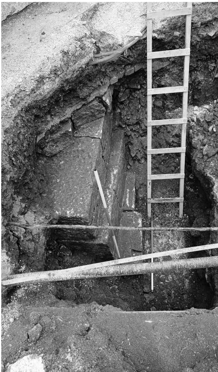
Sl. 9. Temeljna stopa četvrtaste kule na matičnoj stijeni (snimila Kristina Gergeta Sotončić)
