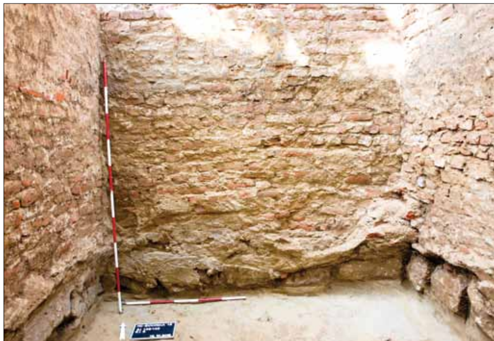
Slika 6. Istraženi temelj zida SJ 6 i potpornjaka SJ 142 i SJ 143 na južnoj strani crkve sv. Nikole (snimio: Robert Čimin, 2015.)
