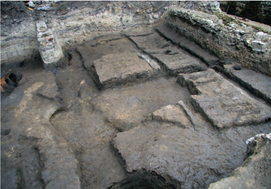
Sl. 21. Ostaci temelja drvene zgrade otkopane 2015. u Parku kraljice Katarine Kosače (Kosača 1, insula B) (snimio A. Paro) / Fig. 21. Remains of the foundations of a wooden building recovered in Park kraljice Katarine Kosače (Kosača 1, insula B) (photo: A. Paro)
