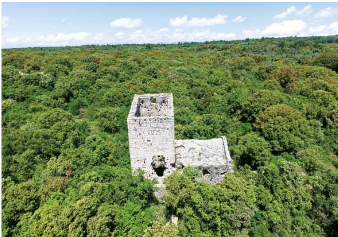
Sl. 15. Zračni snimak romaničke crkve-utvrde sv. Bartula u Petrčanima (foto: J. Šučur) / Fig. 15. Aerial photo of the Romanesque church-fort of St Bartul in Petrčane (photo by J. Šučur)
