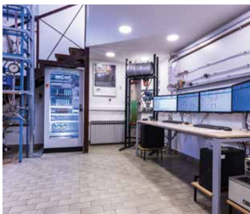
Slika 1: Dio Laboratorija za automatizaciju i mjerenja s operatorskim sučeljem
