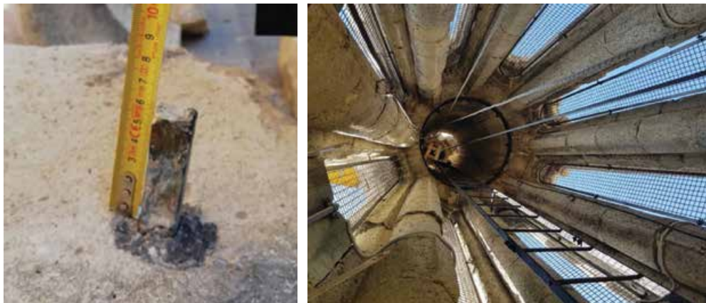
Slika 5: Čelično užje i metalni klin u kamenom bloku
