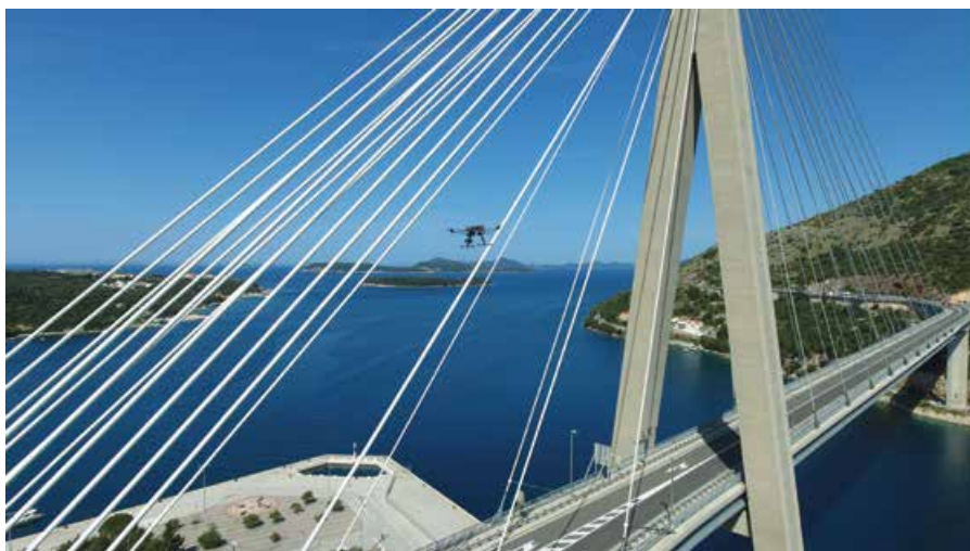
Slika 5: Ispitivanje konstrukcije mosta bespilotnom letjelicom na projektu ASAP
