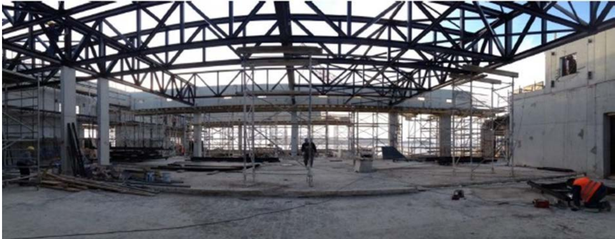
Slika 8. Fotografija rešetkaste konstrukcije krova recepcije hotela tijekom rekonstrukcije 2013. Studio 92 d.o.o., Labin
