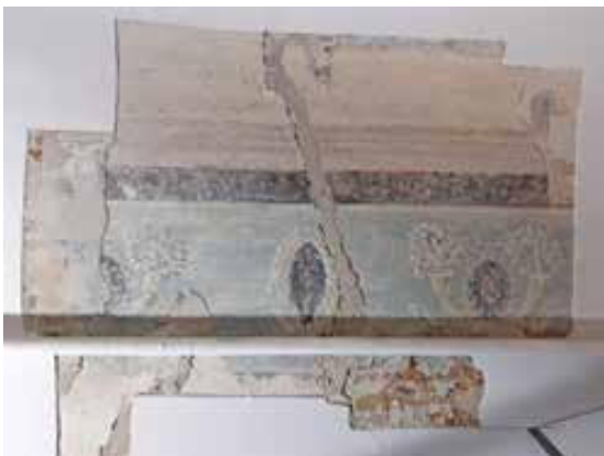
Slika 8. Barokni oslici iz vremena gradnje palače Vojković-Oršić-Kulmer-Rauch pronađeni tijekom sondažnih radova Hrvatskoga restauratorskog zavoda. Fotografirala Matea Brstilo Rešetar.
