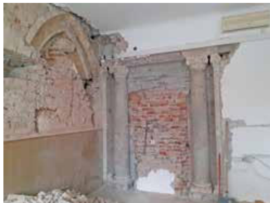
Slika 9. Prolaz s klasicističkim stupovima nekadašnje palače Jelačić otkriven tijekom sondažnih radova Hrvatskoga restauratorskog zavoda u palači Hidrometeorološkog zavoda. Fotografirala Matea Brstilo Rešetar.
