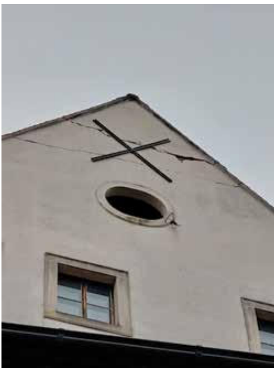
Slika 4. Zatega na oštećenome zapadnom zabatu južnog krila palače Vojković-Oršić-Kulmer-Rauch. Fotografirala Matea Brstilo Rešetar.
