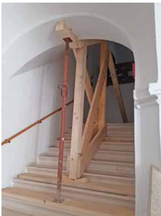
Slika 2. Mjere stabilizacije oštećenog nadvoja južnog stubišta palače Vojković-Oršić-Kulmer-Rauch. Fotografirala Matea Brstilo Rešetar.
