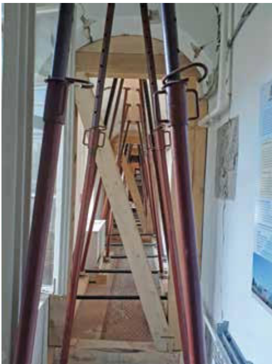
Slika 5. Projekt podupiranja teško oštećene palače Hidrometeorološkog zavoda. Fotografirala Matea Brstilo Rešetar.
