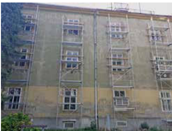
Slika 6. Projekt podupiranja i sapinjanja vanjskih zidova teško oštećene palače Hidrometeorološkog zavoda. Fotografirala Matea Brstilo Rešetar.
