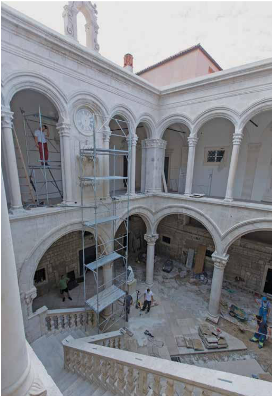
Slika 5. Obnova Kneževa dvora. Izvor: Zavod za obnovu Dubrovnika.
