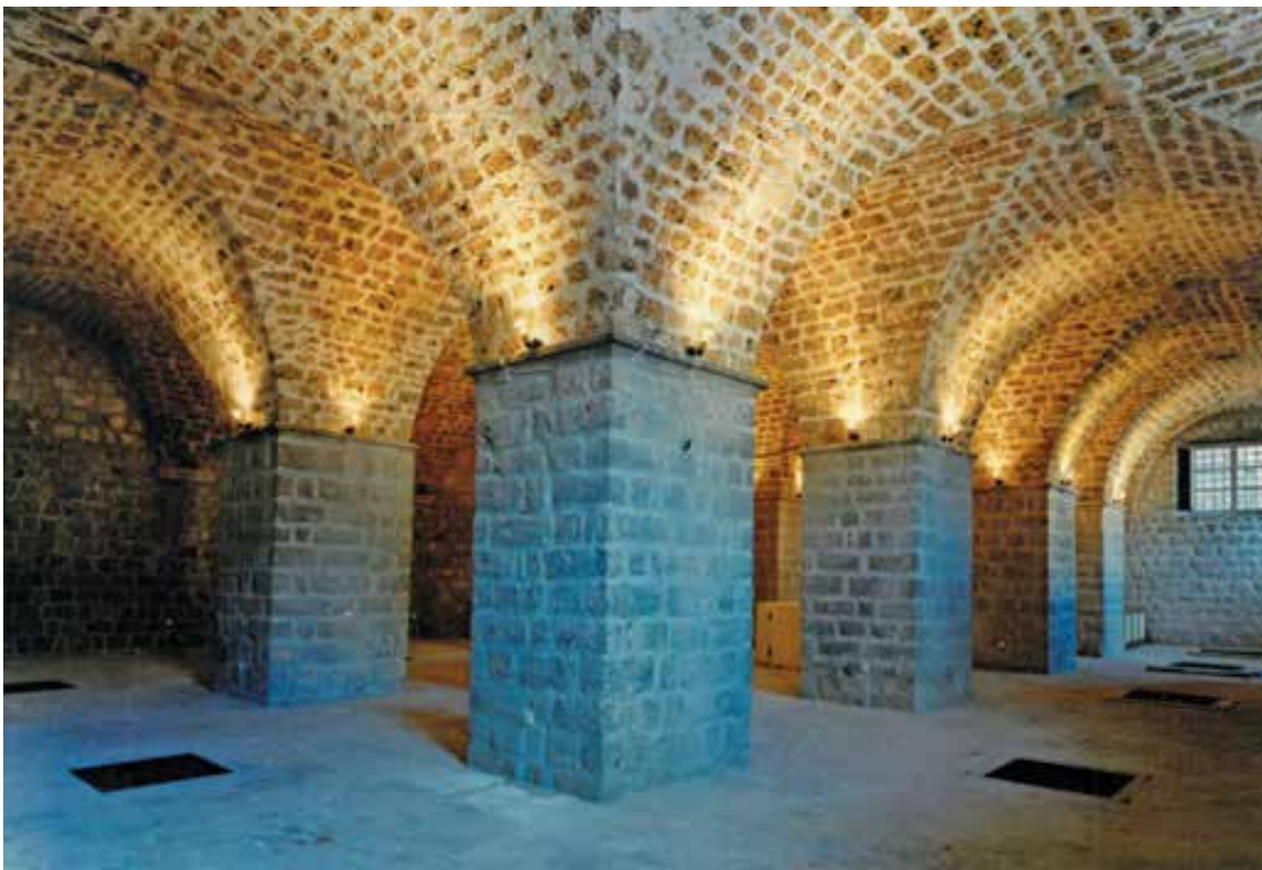
Slika 8. Obnovljen prostor žitnice Rupe. Izvor: Zavod za obnovu Dubrovnika.
