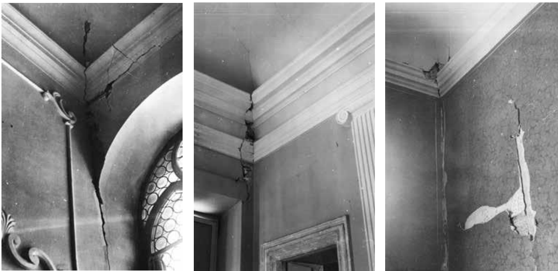
Slike 2 – 4. Oštećenja nakon potresa 1979. u interijeru Kneževa dvora. Fotografirao Miljenko Mojaš.
