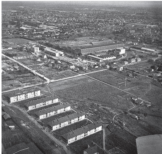
sl.1. Sklop Gradske klaonice u izgradnji, Zagreb, 1930./31., vlasnik: Muzej grada Zagreba
