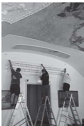
sl.5. Radovi na restauraciji stubišta (foto Marija Lazanja Dušević)
