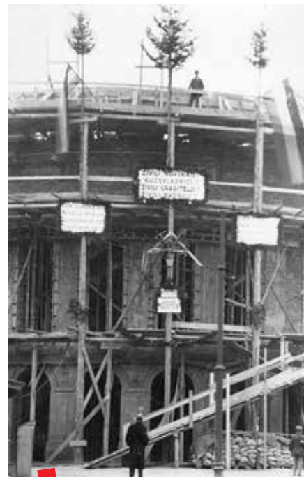
ZAGREB, Rooseveltov trg, Novinarski dom u izgradnji, V. Horvat, 1930. (MKM - FKB, inv. br. 255, br. neg. V-255)
